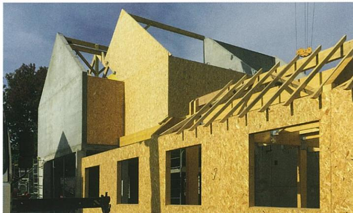
▲ Structure mixte composée de voiles en béton, d'ossatures bois en lamellé-collé et de charpentes en chêne massif.
