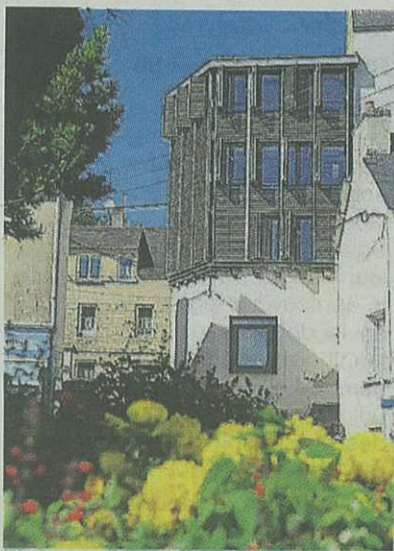
▲ La structure métallique légère permet de ne pas alourdir les fondations d'origine.
