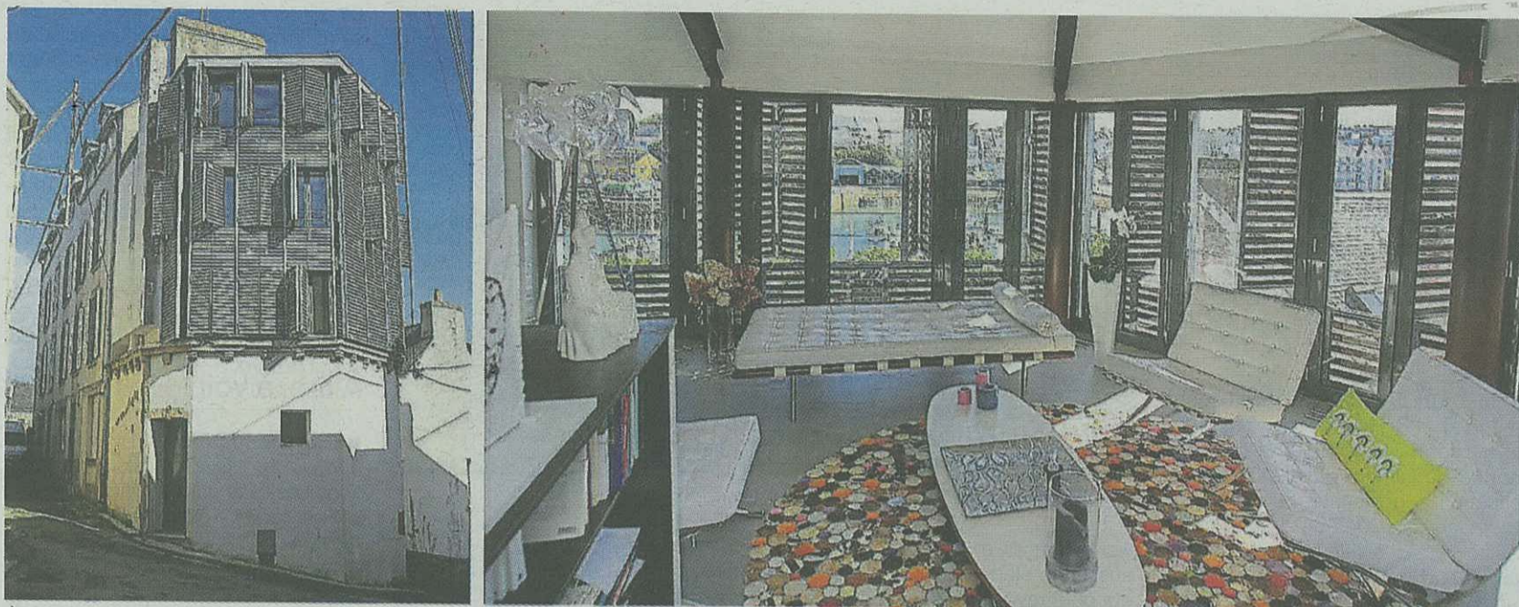
À l'extérieur, la façade vitrée et sa structure métallique disparaissent derrière une seconde peau en bois alors que le salon offre une magnifique vue panoramique.
