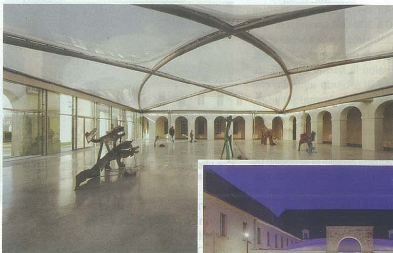
La verrière en membrane ETFE apporte un éclairage optimal au cœur de l'abbaye, tout en évitant la montée en température du volume couvert.
